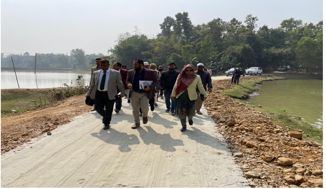
চিত্রঃ ০৫ জনাব মোঃ মিজানুর রহমান, মহাপরিচালক, দুর্যোগ ব্যবস্থাপনা অধিদপ্তর কর্তৃক গাজীপুর জেলার কালিয়াকৈর উপজেলার এইচবিবি রাস্তা পরিদর্শন।
