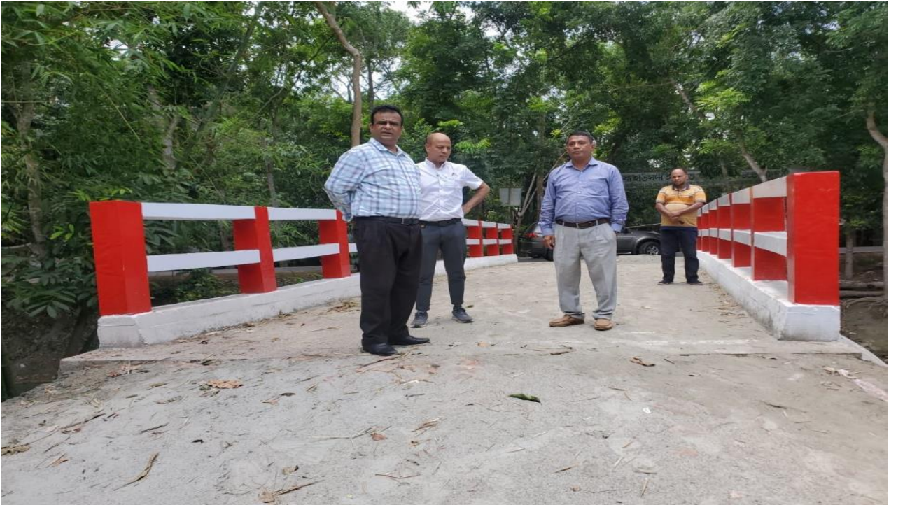
চিত্রঃ ০৪ জনাব মোঃ ইসমাইল হোসনে, উপপ্রকল্প পরিচালক, সেতু/কালভার্ট প্রকল্প, দুর্যোগ ব্যবস্থাপনা অধিদপ্তর কর্তৃক মাদারীপুর জেলার সদর উপজেলায় নির্মিত সেতু পরিদর্শন।
