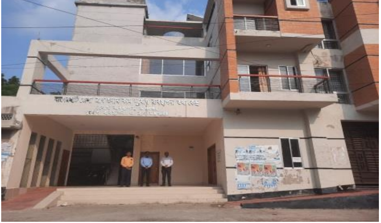
চিত্রঃ ০২ জনাব মোঃ মিজানুর রহমান, মহাপরিচালক, দুর্যোগ ব্যবস্থাপনা অধিদপ্তর, ঢাকা কর্তৃক বান্দরবান জেলা ত্রাণ গুদাম কাম দুর্যোগ ব্যবস্থাপনা তথ্য কেন্দ্র নির্মাণ প্রকল্প পরিদর্শন।
