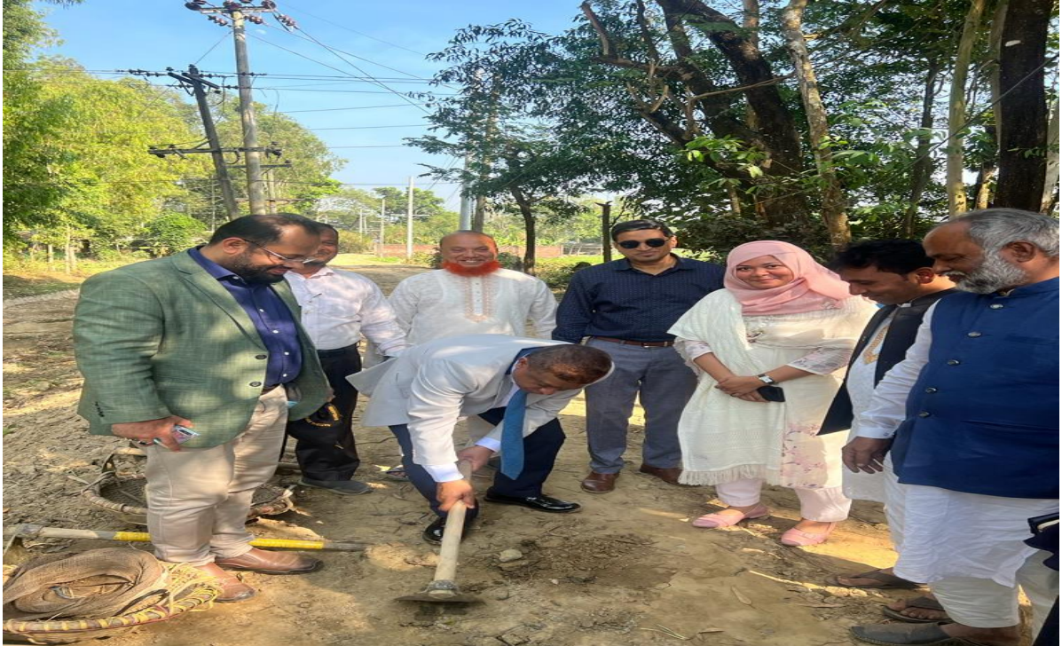
চিত্রঃ ০২ জনাব মোঃ মিজানুর রহমান, মহাপরিচালক, দুর্যোগ ব্যবস্থাপনা অধিদপ্তর, ঢাকা কর্তৃক অতিদরিদ্রদের জন্য কর্মসংস্থান কর্মসূচি (ইজিপিপি) এর আওতায় পূর্ব সাতবাড়ীয়া বাগিচাহাট হতে সাতবাড়ীয়া বরমা সংযোগ সড়ক পর্যন্ত রাস্তা সংস্কার ও মাটি ভরাত কাজ পরিদর্শন।
